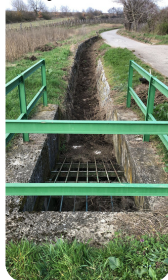
Freimachen der verlegten Einlaufstellen
